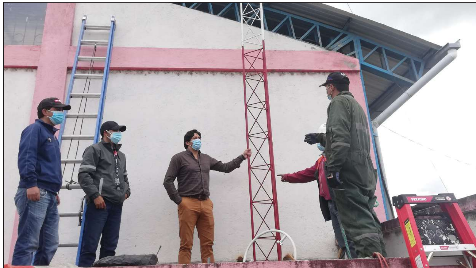
Técnicos de la Unidad de Sistemas del GAD Montúfar, realizan la instalación de los equipos para las zonas wifi.
